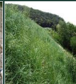
Rilevati con terreno vegetale - Toscana
